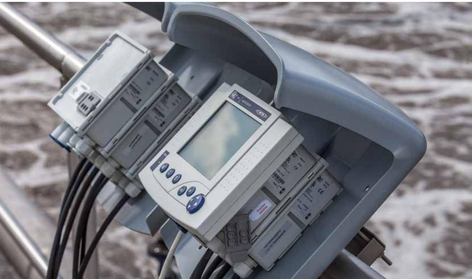
Wir bieten für das IQ SENSOR NET eine umfassende Auswahl an Montagezubehör. Ob Kanal, Becken oder Rohreinbau - ob Wand-, Geländer- oder Bodenmontage. Neben fertigen Sets bieten wir auch alle Produkte als einzelne Lieferumfänge an, damit Sie die Sensoren und Geräte nach Ihren Bedürfnissen installieren können.
